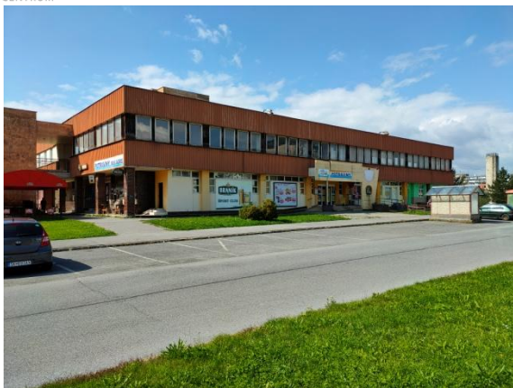
Vstup z východnej strany
