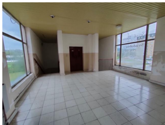
Schodisko a výtah z južnej strany
