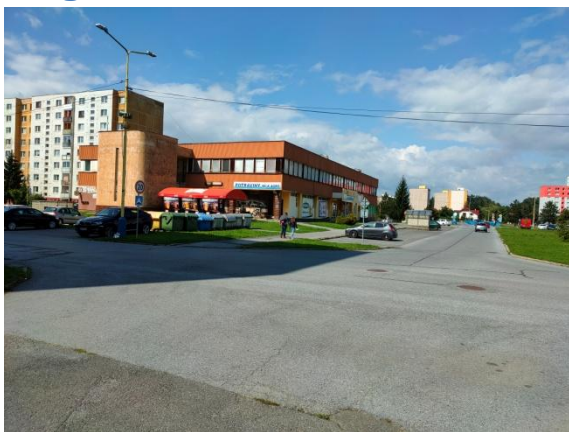
Pohľad z východnej strany
